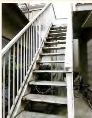
工事前の様子
